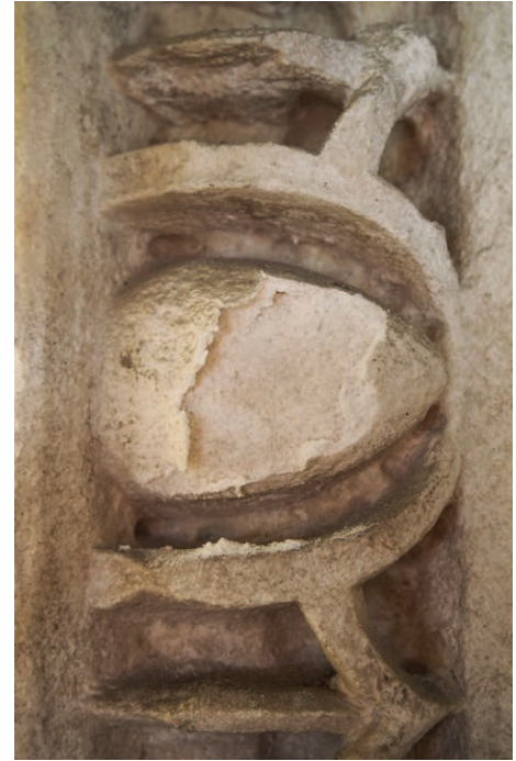
Slika 4: Primer nekompatibilnosti utrjevalca na kamnitih elementih, ki je privedel do luščenja
