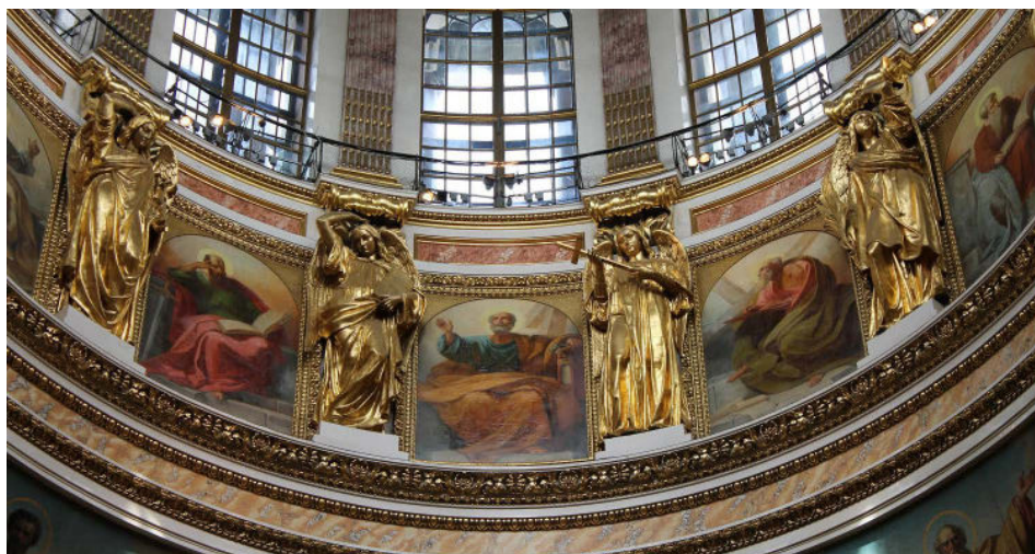
Slika 2: Notranjost kupole katedrale sv. Izaka v St. Peterburgu krasi dvanaest 6 metrov visokih pozlačenih angelov kiparja Josefa Hermanna (1800–1869). Kipi so verjetno sploh prvi primer arhitekturne plastike, izdelane z galvanoplastično tehniko. Debeli so le nekaj milimetrov in zato izjemno lahki glede na velikost, kar je bilo pri načrtovanju in gradnji kupole (1837–1841) velikega pomena.
