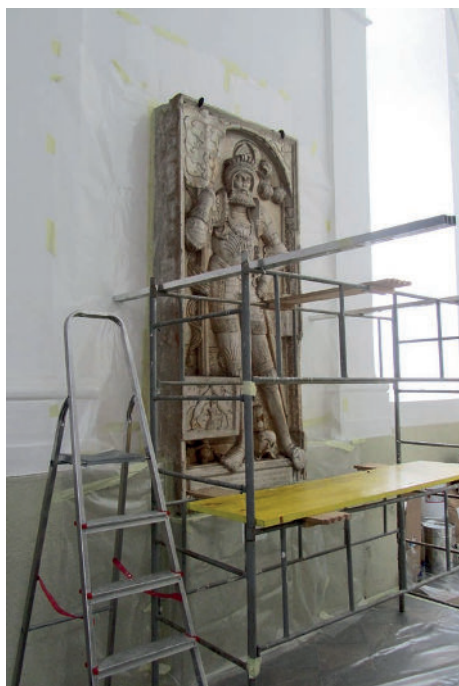
Slika 6b: Izdelava kalupa: priprava delovišča, zaščita stene in tal ter zaščita spomenika s polivinil alkoholnim lakom
