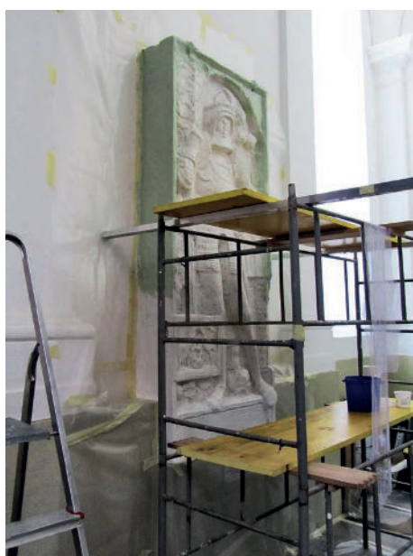
Slika 6d: Izdelava kalupa: nanos druge, s tanko poliestrsko armaturno mrežico (stare zavese) ojačane plasti silikonskega kavčuka. Zaradi kontrole debeline je bila guma obarvana z zelenim pigmentom.
