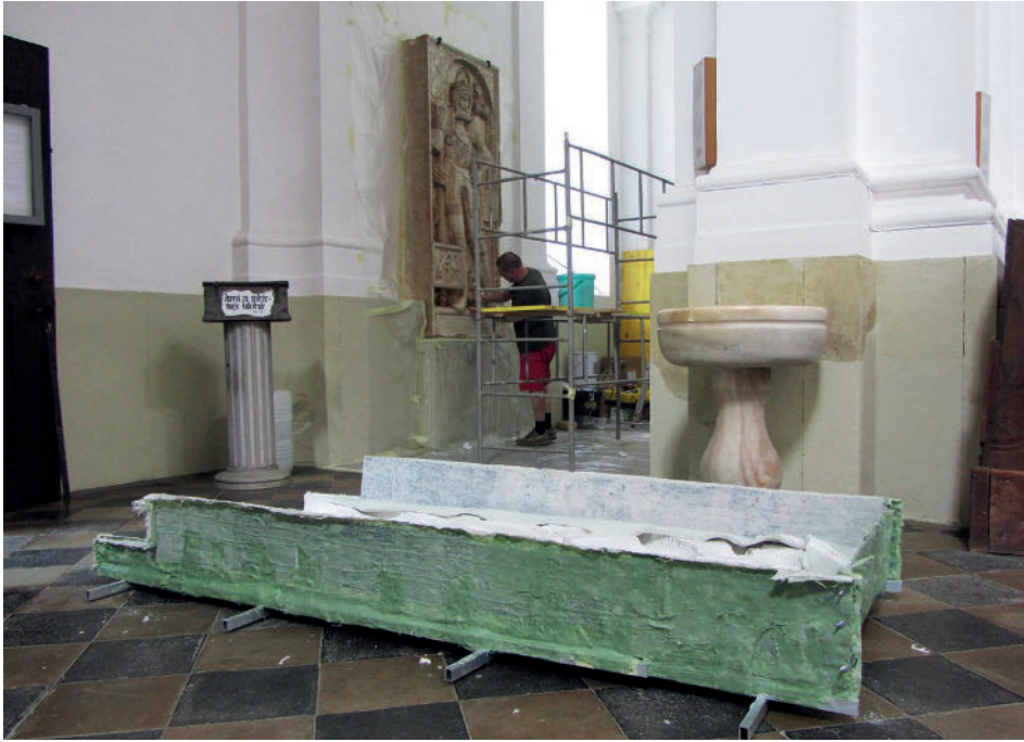
Slika 6g: Izdelava kalupa: po odstranitvi kalupa je sledilo odstranjevanje vodotopnega zaščitnega laka in vrnitev originala in prostora v prvotno stanje.
