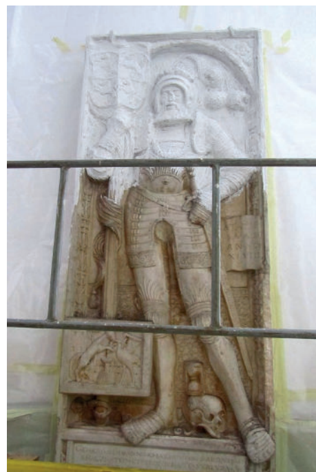
Slika 6c: Izdelava kalupa: nanos proe plasti silikonskega kavčuka
