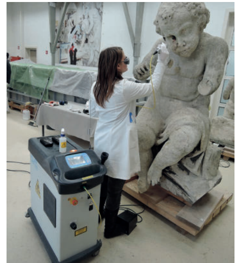
Slika 9: Lasersko odstranjevanje črnih oblog na kamnitem kipu muzicirajočega dečka iz SNG Maribor.
