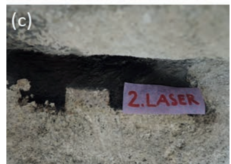
Slika 10: Odstranjevanje črne obloge s kamnite površine: (a) pred čiščenjem, (b) prvo čiščenje, (c) drugo čiščenje – debelejša črna obloga odstranimo z večkratnim čiščenjem z laserjem.
